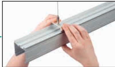
Rasten Sie die Systemschiene in die Bügel der Abhänge-Sets ein
