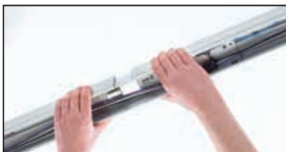
Richten Sie die Systemschienen passend zueinander aus und schieben Sie die Anschlüsse zusammen
