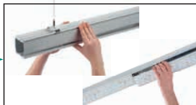
Rasten Sie den Leuchteneinsatz in die Systemschiene ein
