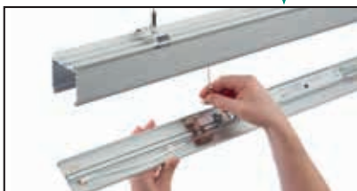
Sichern Sie den Leuchteneinsatz mit der Fangkette an der Systemschiene
